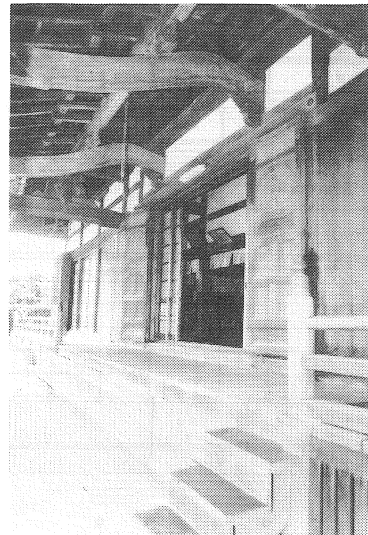
写真3 本堂前面の向拝下
