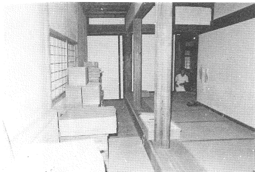
写真33 後補の北飛檐間及び落間
