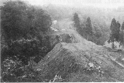
写真9. 信越本線の被害
