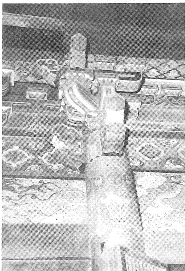
写真14 内陣・余間前柱の上部
