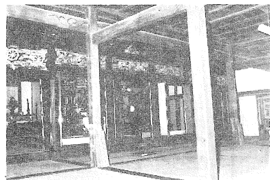
写真5 外陣から矢来上の繫虹梁、内陣前の欄間、内陣を見る
