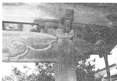
写真 12 向拝虹梁端部
