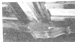
写真4 正面中央間の扉構え下部
