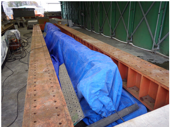
蒸気養生状況
