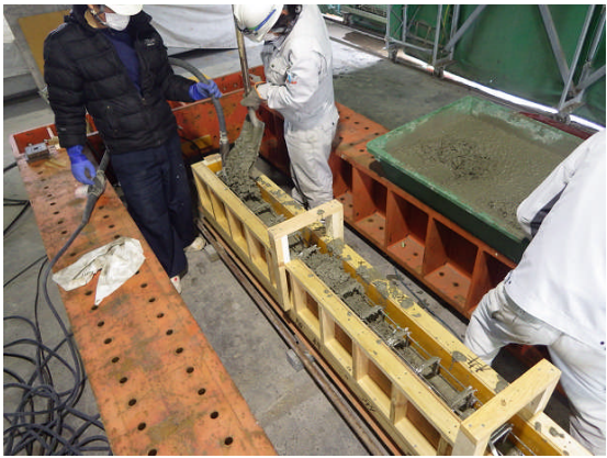
コンクリートの打ち込み状況
