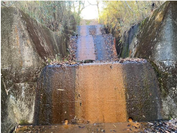
写真1 大洞砂防池 流出口の河川横断工作物
