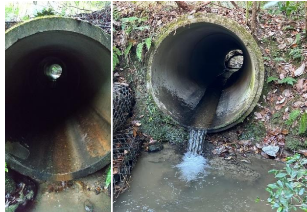
写真2 吉田川 コンクリート製パイプカルバート (左・下流側 右・上流側)
