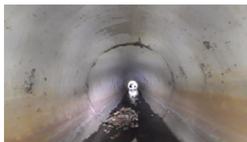
図2：カルバート管内部の様子
