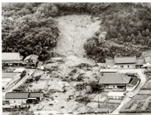
図-5 斜面崩壊によって被害を受けた家屋 4)
