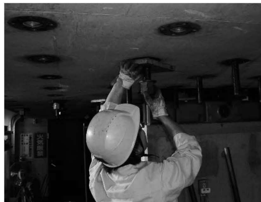
[写真3] ナットの仮締め
