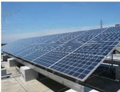
太陽光発電装置 (10 kW, 10 kW)
