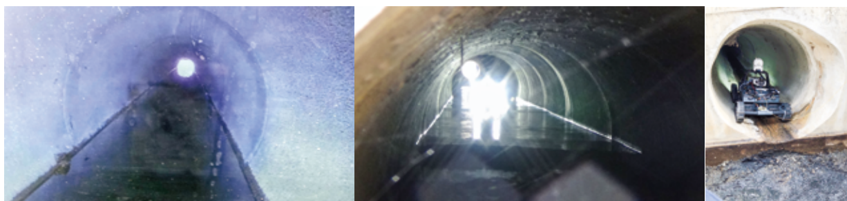
図5：カルバート内点検検証実験の様子（2018年2月16日）
