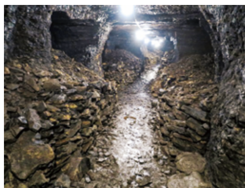
図1. 亜炭鉱坑道内部
