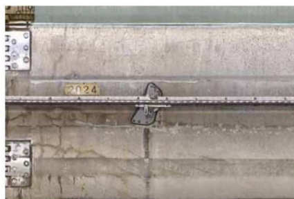
写真 3.2 PC 軌道桁の ASR による損傷状況の事例 3.5)
