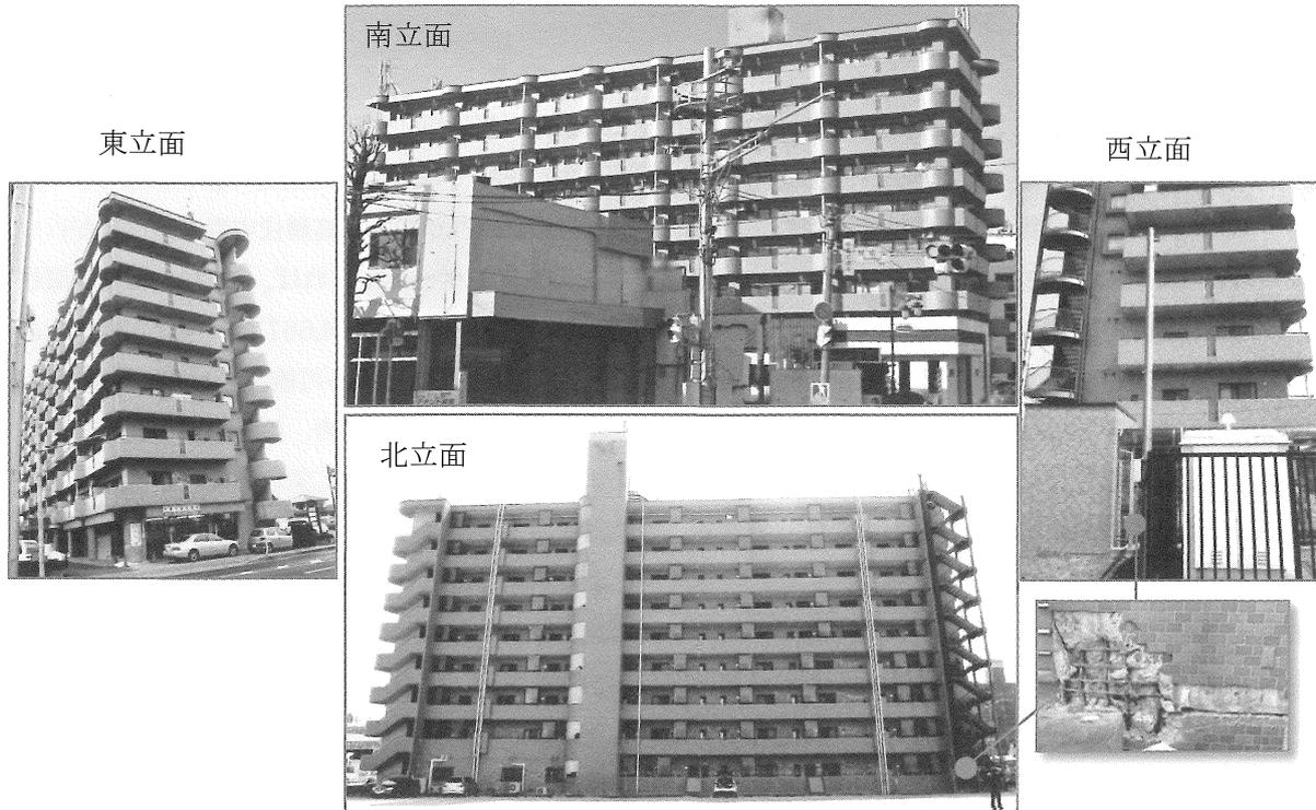
写真1 常時微動を観測した9階建SRC造集合住宅（建物QM）；撮影時間：2011年4月
