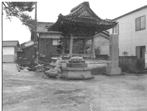
写真4 法相寺の鐘楼が外れ転落（青シート）。 灯籠も上部が転落。
