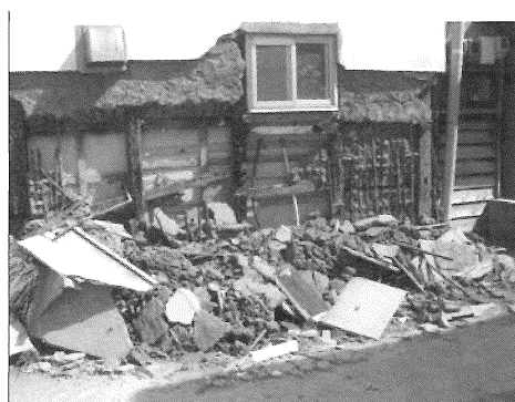
写真2 土壁の崩落
