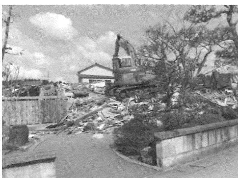
写真1 宮森旅館取り壊し状況
