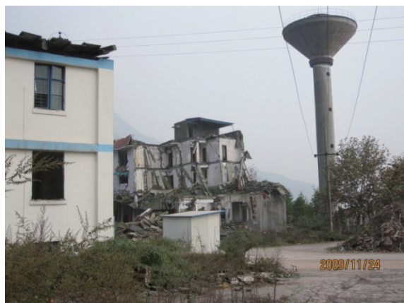
写真6 3つの異なる構造物被害（2009.11.24 撮影）
