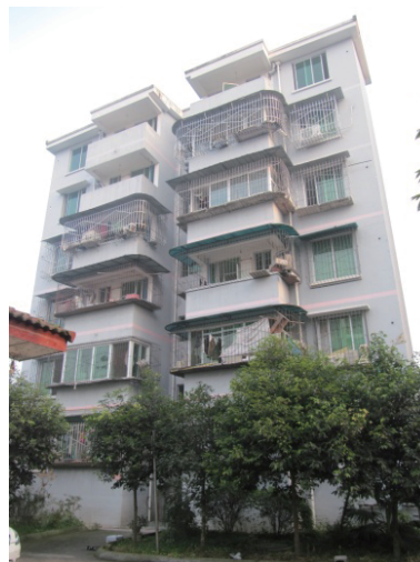
写真11 綿竹市における無被害建物A
