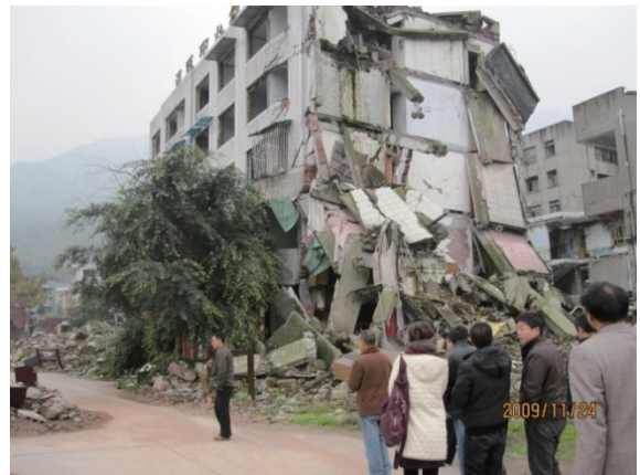
写真 4 漢旺鎮中心部の被害 (2009.11.24 撮影)
