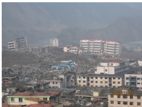
写真7 北川市中心部の被害（2009.11.25 撮影）
