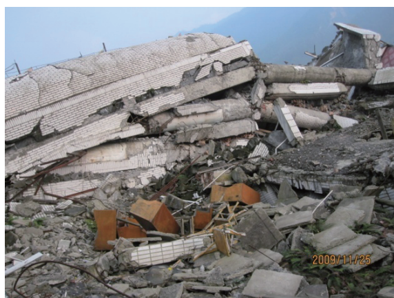
写真8 北川市5階建てビルの崩壊（2009.11.25 撮影）
