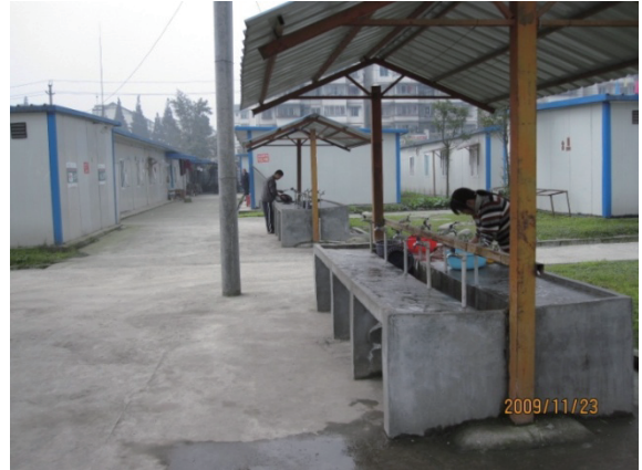
写真 3 都江堰市の仮設住宅 (2009.11.23 撮影)
