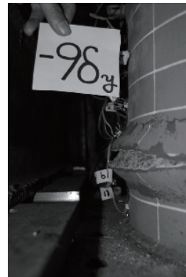
(a) C1.5D-T6.0A 基部の座屈に発生したクラック
