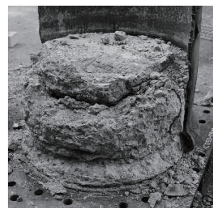
(e) C0.5D-T9.0D コンクリートの損傷 (ジベル有り)
