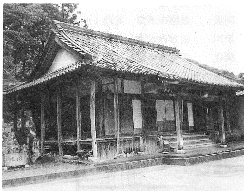
写真-10 観音寺（車川）本堂外観
